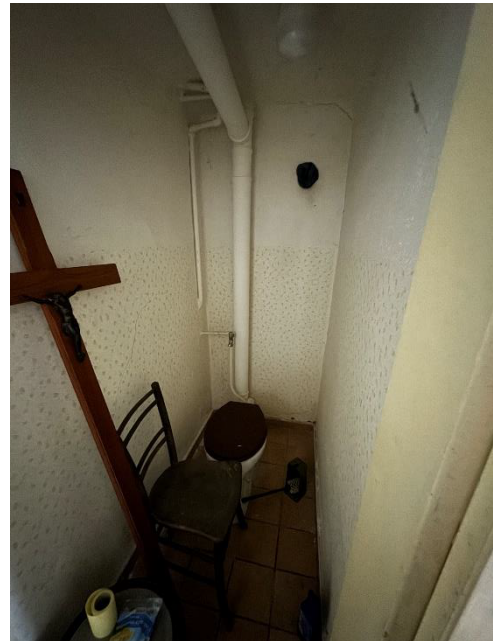
Bild 14 von 30 Blick in das WC
