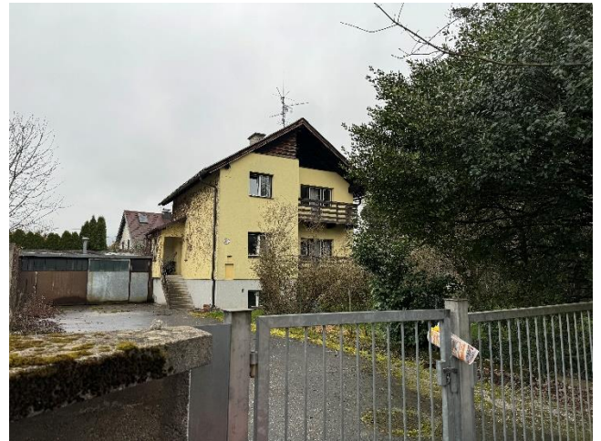
Bild 2 von 30 Ansicht aus Westen
