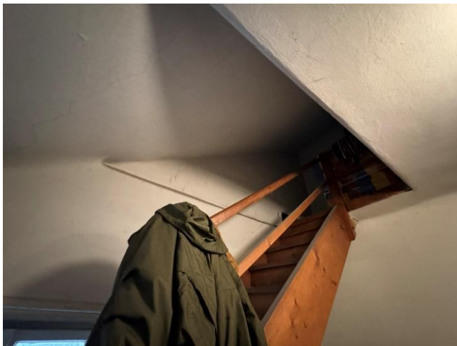
Bild 21 von 30 Blick auf den Eingang in den Dachboden
