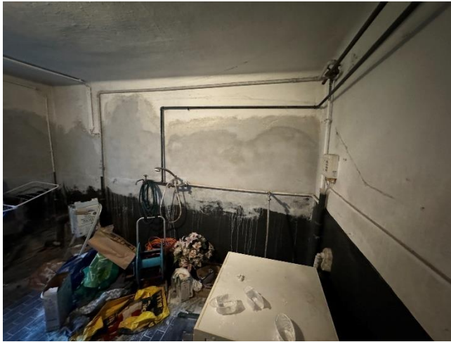
Bild 9 von 30 Blick in einen Kellerraum
