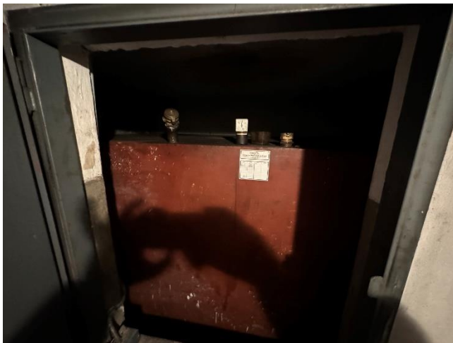
Bild 13 von 30 Blick auf den Öltank (Keller lt. Einreichplan)
