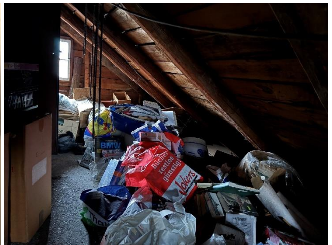
Bild 22 von 30 Blick in den Dachboden
