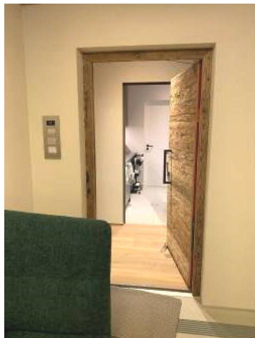
Der Hauswirtschaftsraum ist mit einer Pfostenstocktüre, wie zuvor bereits beschrieben, abgegrenzt. Im Hauswirtschaftsraum ist auf der Nordseite eine Arbeitsküche mit einem Waschbecken, ausziehbaren Kästen, Schubladen und vierteiligen Oberkästen eingebaut. Am Boden sind Steingutfliesen verlegt.
