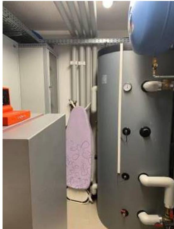
In diesem Bereich steht die Heizanlage mit der Gastherme, ein Pufferspeicher, die Warmwasseraufbereitungsanlage und hinter der Tür wurde für den Anschluss einer Luftwärmepumpe Vorsorge getroffen worden.
