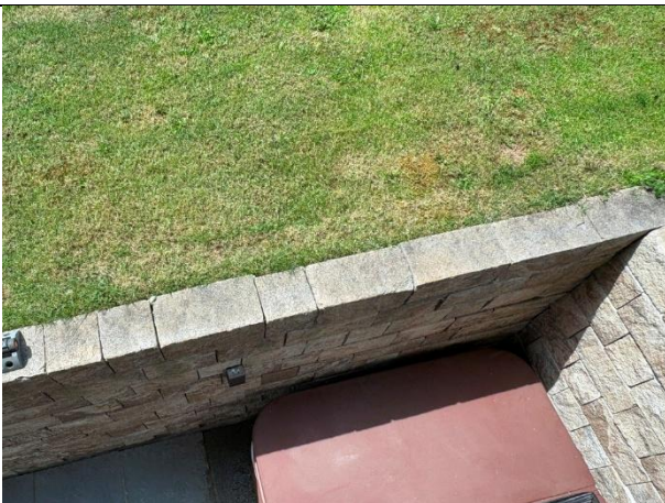
Abbildung 160: Blick auf Terrasse im UG
