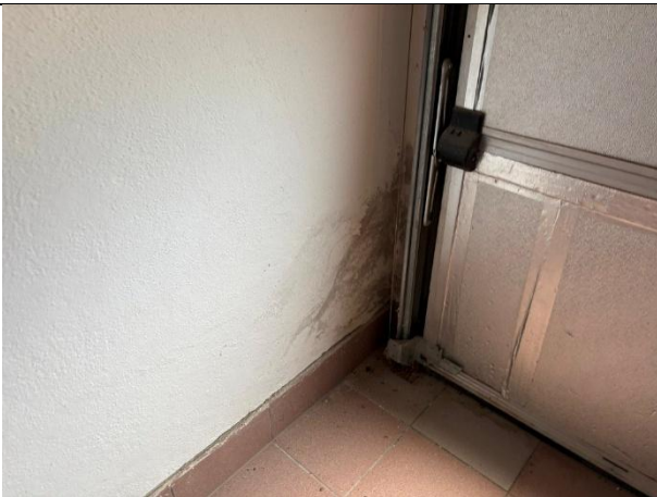
Abbildung 260: Bsp. Feuchtigkeitsschäden
