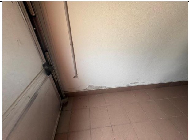
Abbildung 261: Bsp. Feuchtigkeitsschäden
