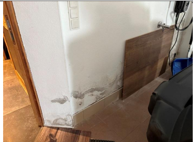
Abbildung 255: Bsph. Feuchtigkeitsschäden
