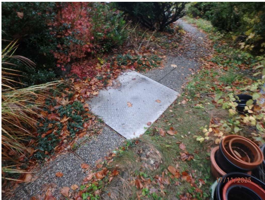
Öltank mit Riffelblechabdeckung
