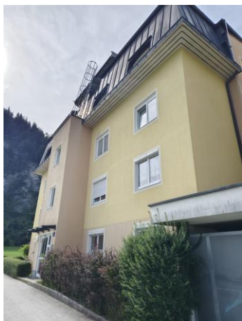
Abbildung 26: Außenansicht des Gebäudes
