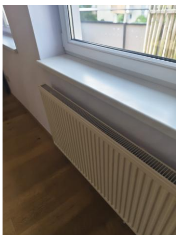
Abbildung 48: Wohnzimmer Fensterbank und Heizkörper
