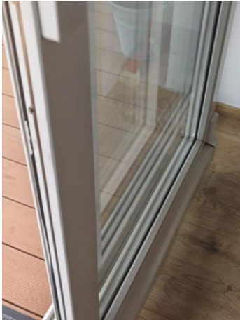
Abbildung 50: Schiebetür / Ausgang zur Dachterrasse
