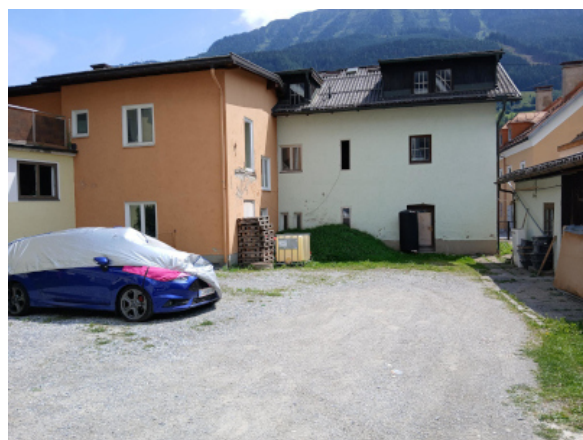
Beide Bestandsobjekte Ansicht von Norden, vom Parkplatz
