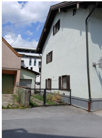
Sicht zur Einfahrt Nebengebäude
