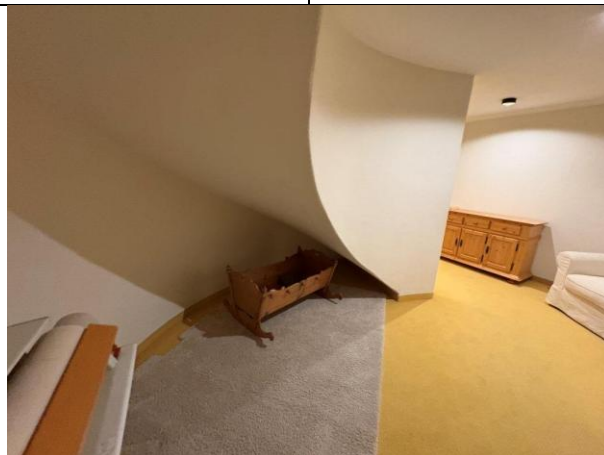
Abbildung 190: Stiege EG/Keller & Flur Keller
