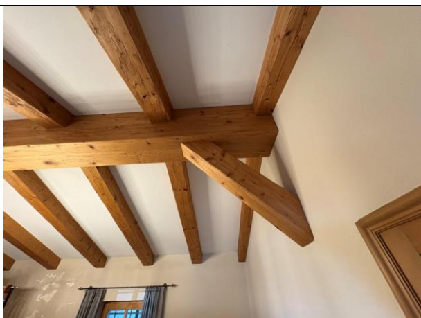
Abbildung 65: Bsp. Sichtdachstuhl
