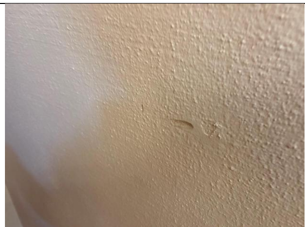
Abbildung 218: Bsph. Putzschäden
