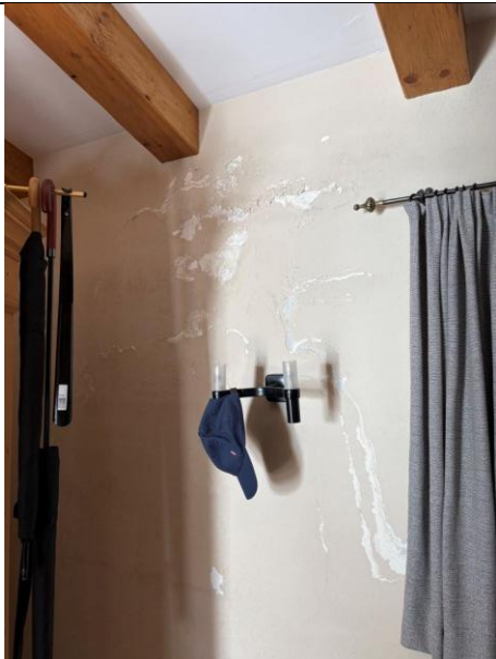
Abbildung 215: Bsph. Putzabplatzungen
