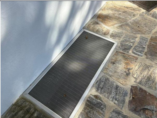
Abbildung 53: Bsph. Bodenbelag / Kellerschacht
