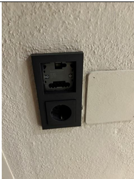
Abbildung 221: fehlende Blenden
