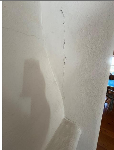
Abbildung 216: Bsph. Setzungsrisse
