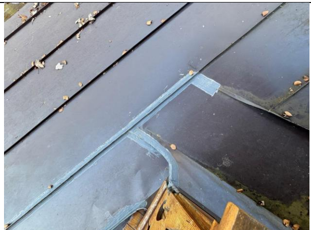
Abbildung 181: Dachansicht; Ausbesserungen
