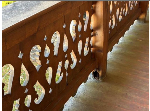
Abbildung 185: Bsph. morsche Brüstungsstütze
