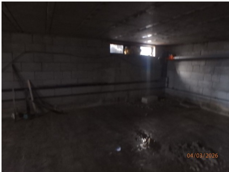
Aufnahmen im Keller.
