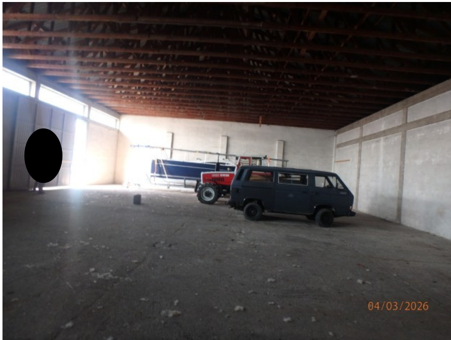
Aufnahmen in der Halle mit Einbauten-Büro.
