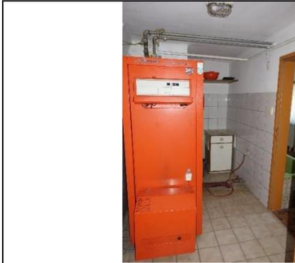
**Heizungsaufstellungsraum:** Boden: Fliesen; Wände: Fliesen ca. 1,7 m hoch; restliche Wände und Decke: verputzt und gemalt; 1 Heizkessel mit Ölbrenner (Fabrikat Viessmann Vitola biferral; Heiznennleistung: 18 kW)
