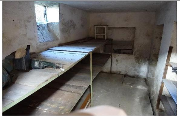
**Keller:** Boden: Beton; Wände und Decke: verputzt und geweißt; teilweise erkennbare Feuchtigkeitsschäden am Wandputz;
