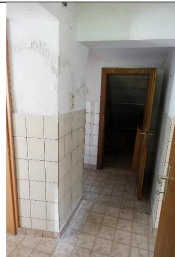
**Vorraum:** Boden: Fliesen; Wände: Fliesen ca. 1,5 m hoch, restliche Wände: verputzt und gemalt; Decke: verputzt und gemalt; erkennbare Feuchtigkeitsschäden im Wandbereich über der Verfliesung;
