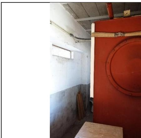
**Zubau-Tankraum:** Boden: Beton versiegelt; Wände: verputzt und gemalt und versiegelt; Decke: Betonziegeldecke unverputzt; 1 Stahlplattentank ;
