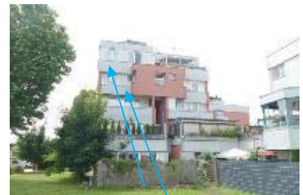
Nord – Blick auf W 7/3/7
