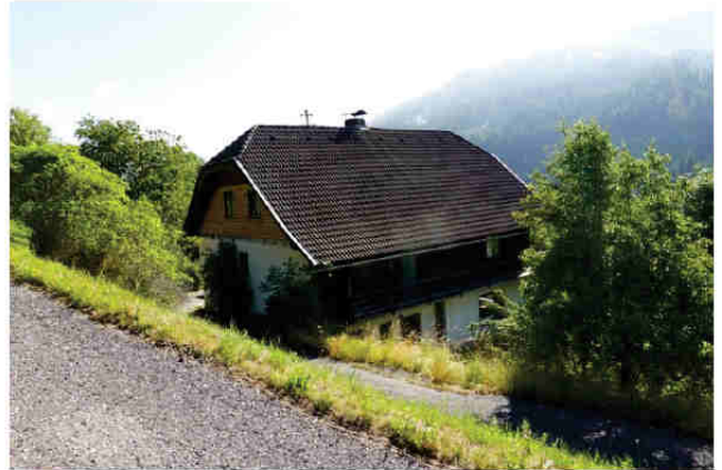
Wohnhaus von Osten
