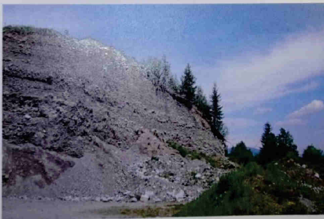
Abb.2: Rechter Wandbereich, Blick nach NO, ungegliederte Wandhöhe ca. 25 m.
