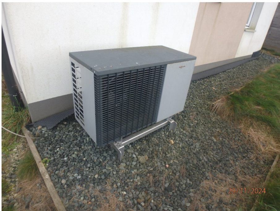
Luftwärmepumpe – Außengerät.
