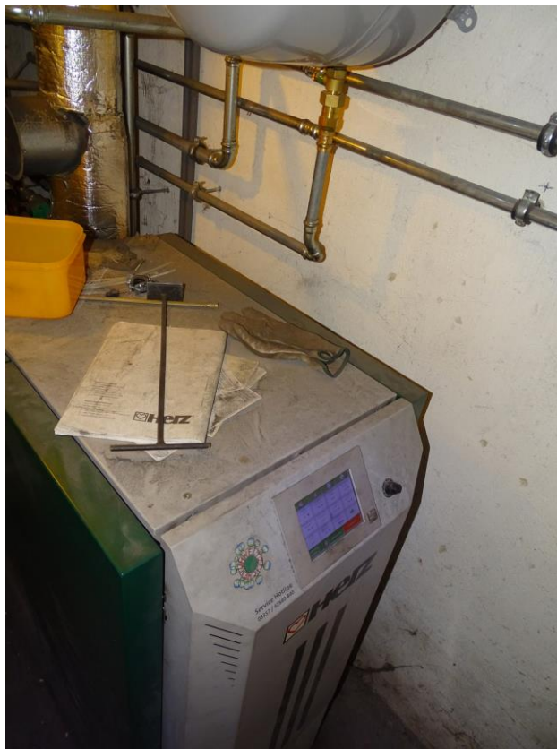
Pellets-Heizkessel Baujahr 2015
