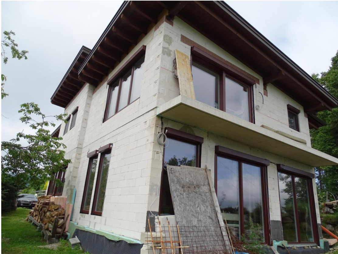
Gebäudeansicht Nordost mit zweigeschossigem Ytong-Zubau aus dem Jahre 2021
