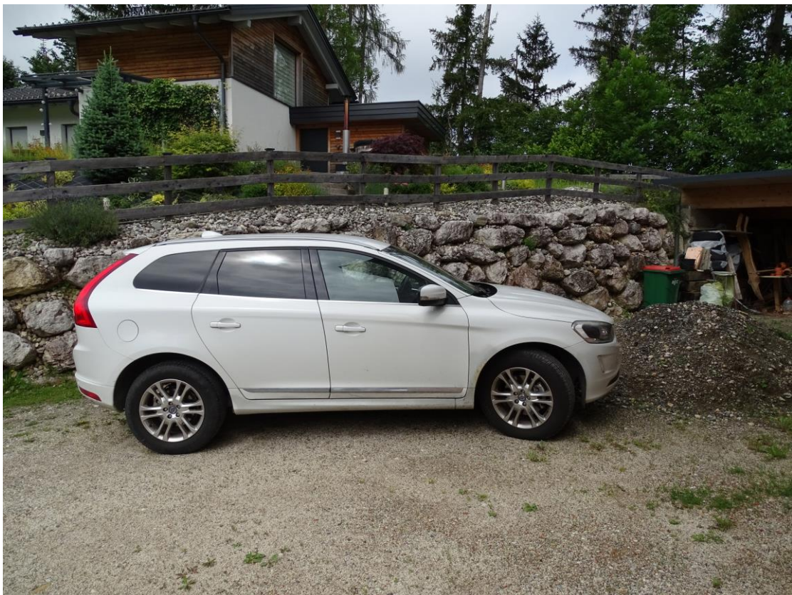
Steinschichtung als Stützwand entlang der Südseite der Grundstückszufahrt
