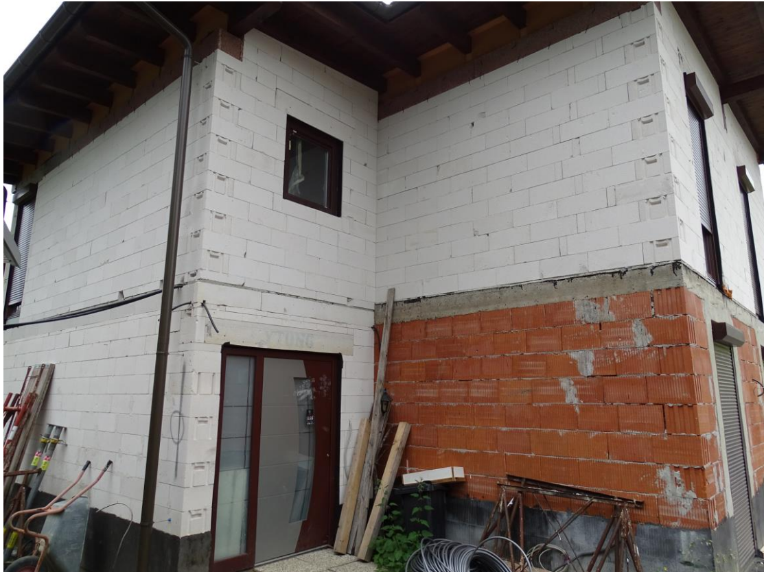
Gebäudeansicht Südwestseite mit Stiegenhausanbau und hofseitigem Wohnhauszugang
