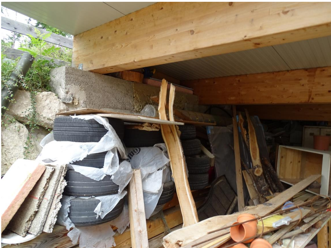
Stützwandausbildung an der Südseite des Unterstellplatzes mit Leimbinderträgern und Sandwichpaneelen
