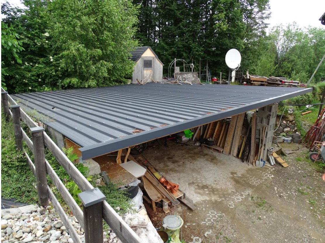
Flugdach als KFZ- Unterstellplatz – Dachansicht Ostseite
