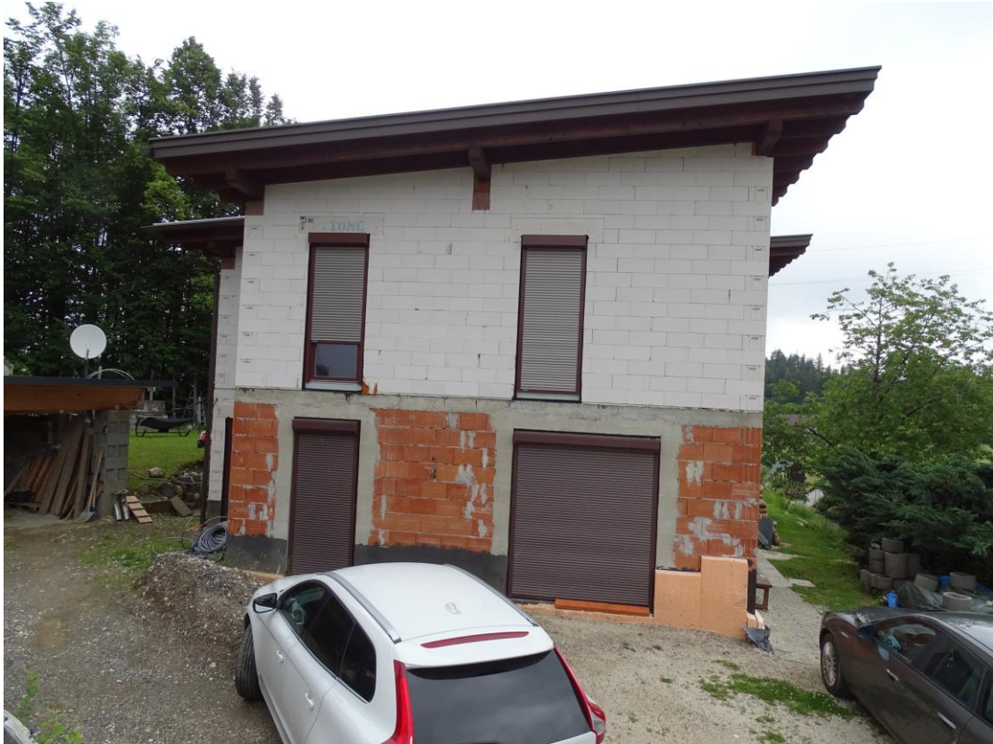
Gebäudeansicht Südseite mit EG-Anbau 2015 und Aufstockung 2021
