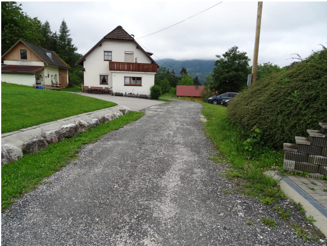
Privater Zufahrtsweg Parzelle 731/2 an der Südseite als Schotterstraße
