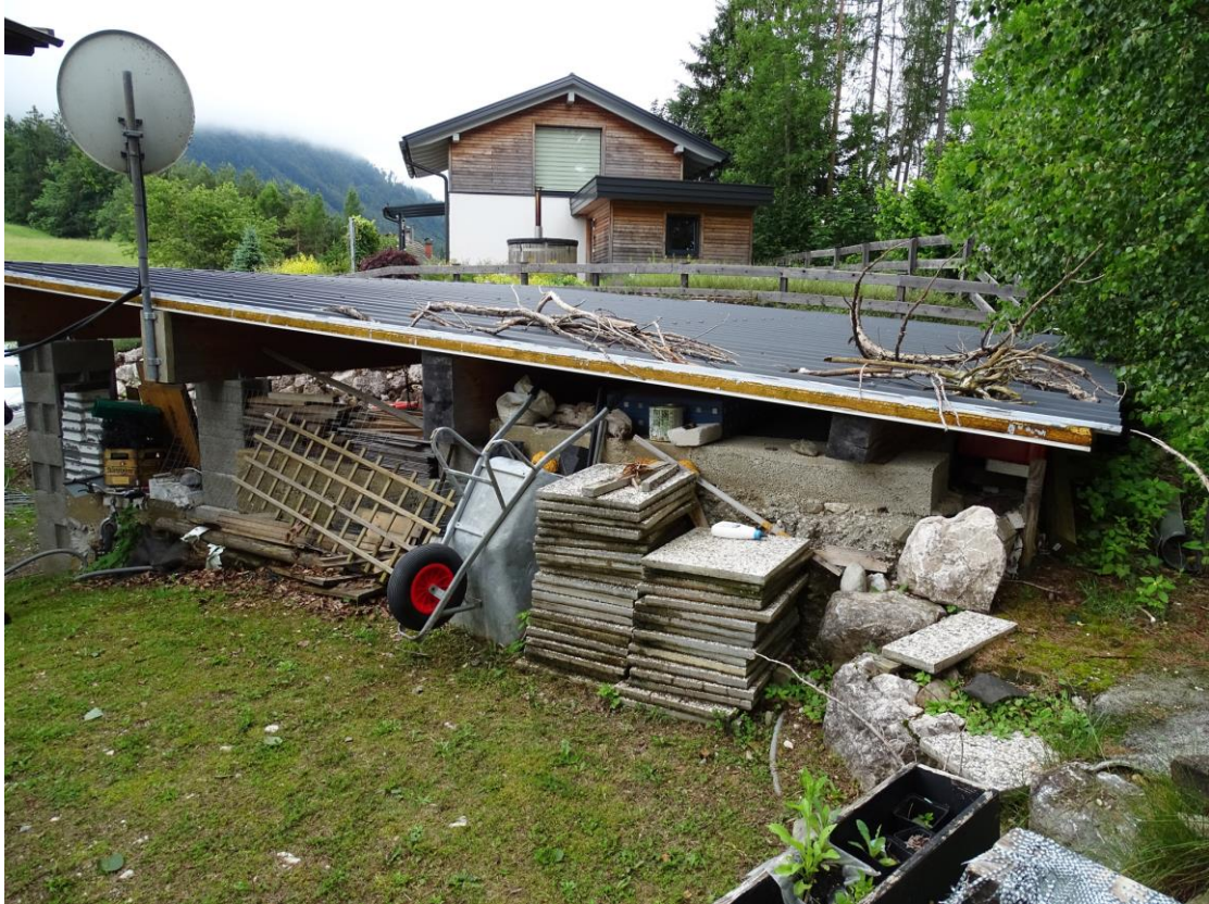
Flugdachkonstruktion - Gebäudeansicht von der Nordseite
