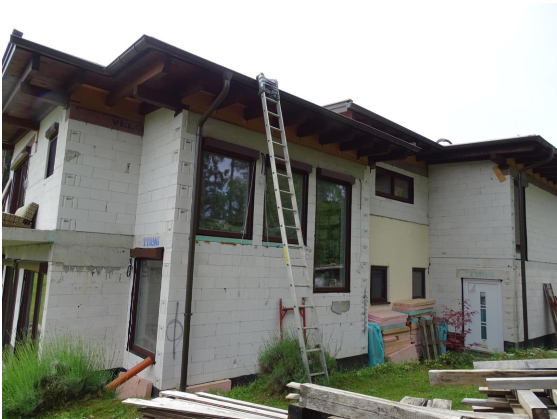
Gebäudeansicht Nordwest mit Zubau und sichtbarer Aufstockung des Altbestandes im Mitteltrakt
