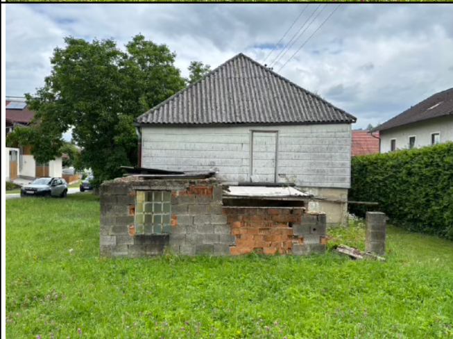
Westansicht Fassade eternitvertäfelt; Im Vordergrund Garage als Abbruchobjekt.
