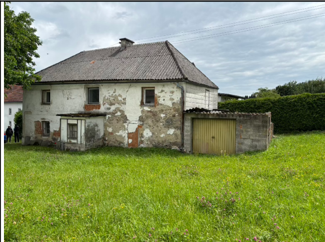
Nordwestansicht. Windfang auf Fremdgrund, Garage nicht bewilligt
