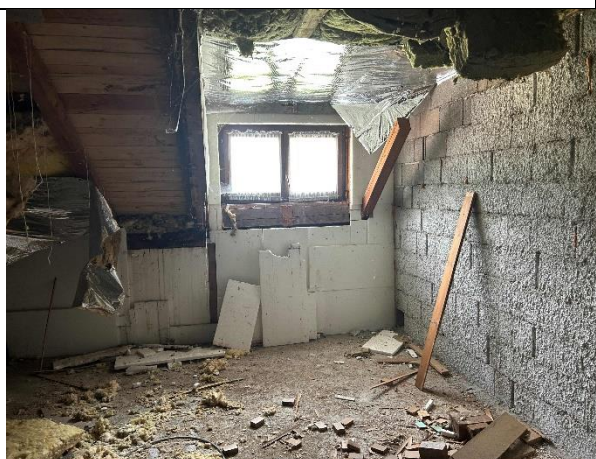
Dachgeschoß nicht ausgebaut, fehlende Dämmung
