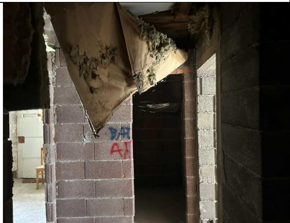
Dachgeschoß nicht ausgebaut, fehlende Dämmung
