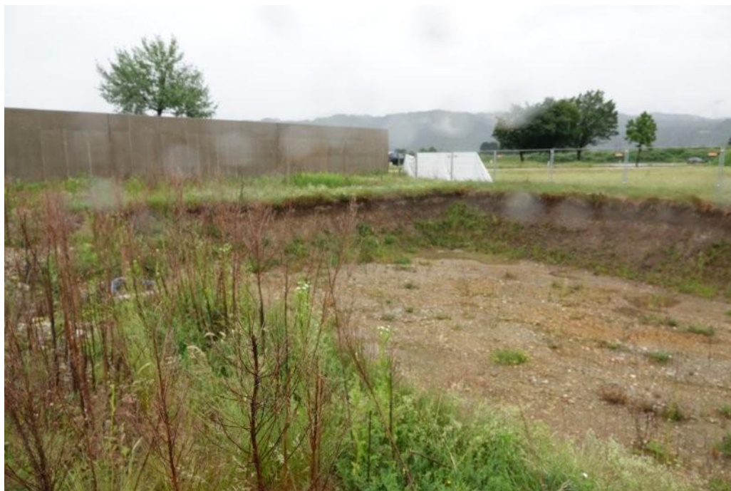
Abbildung 11 Baugrube im Süden
