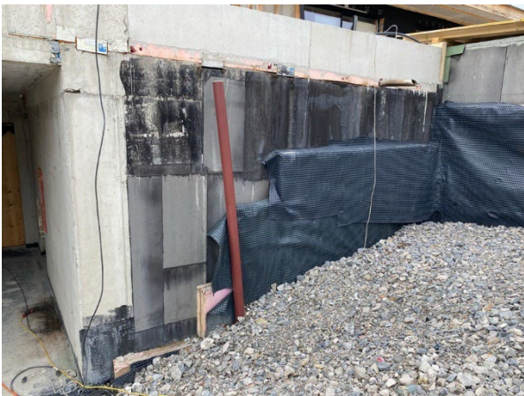
Abbildung 47, beschädigte Perimeterdämmung
