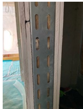
Abbildung 86, Doppelte Beplankung
