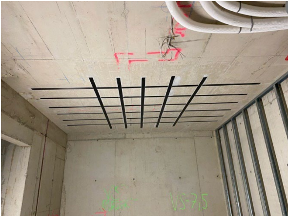
Abbildung 61, UG1, Fitness, CFK Bewehrungsverstärkung
