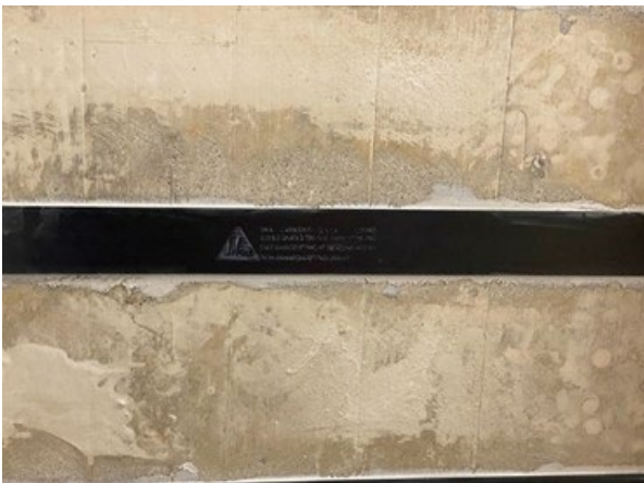
Abbildung 101, CFK Zusatzbewehrung
