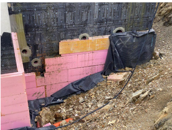
Abbildung 41, beschädigte Perimeterdämmung
