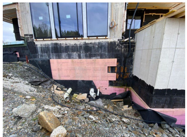
Abbildung 42, beschädigte Perimeterdämmung
