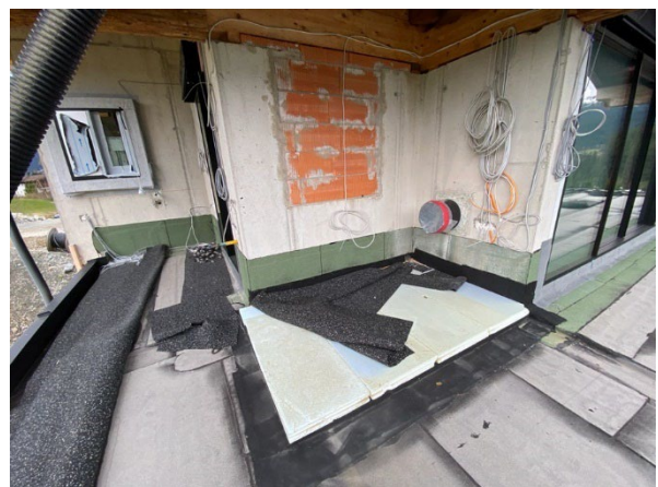
Abbildung 170, OG, Balkon Nord-West
