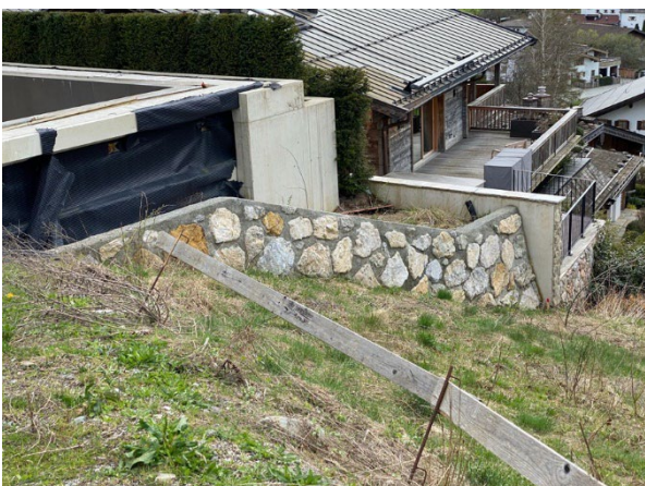
Abbildung 33, Steinschichtung
