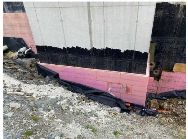
Abbildung 40, beschädigte Perimeterdämmung
