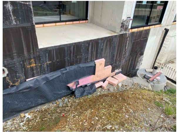
Abbildung 28, beschädigte Perimeterdämmung
