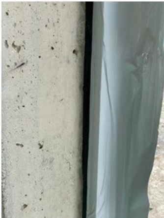
Abbildung 151, EG, Vorraum, Fensteranschlüsse
