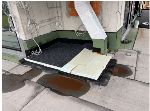
Abbildung 168, OG, Balkon Nord-West
