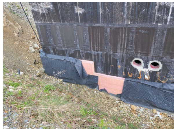
Abbildung 26, beschädigte Perimeterdämmung
