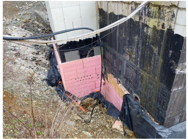
Abbildung 36, beschädigte Perimeterdämmung
