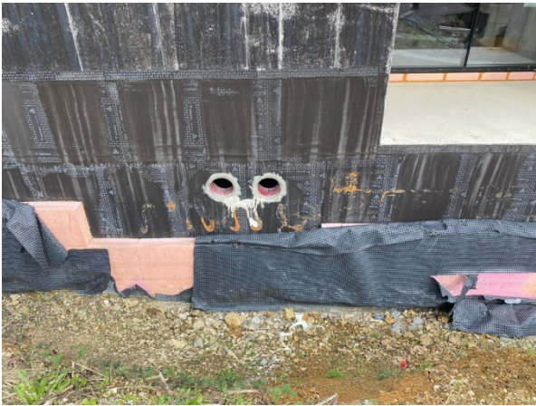
Abbildung 27, beschädigte Perimeterdämmung
