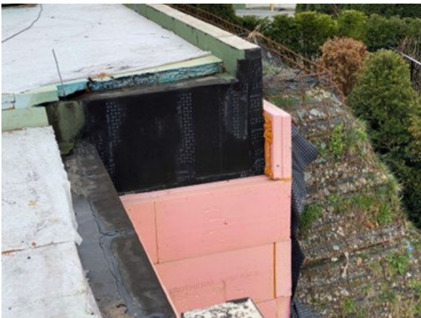
Abbildung 127, EG, Perimeterdämmung Süd
