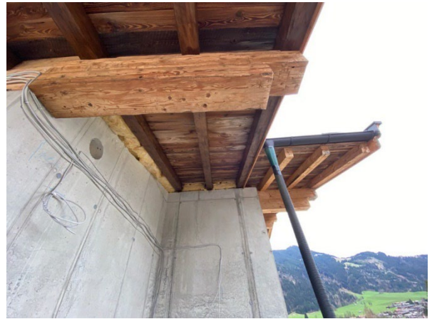
Abbildung 156, OG, Untersichten Dach
