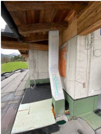
Abbildung 183, OG, Terrasse Süd-West
