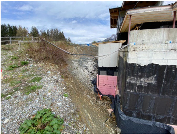
Abbildung 35, Aushub mit Felsabbruch
