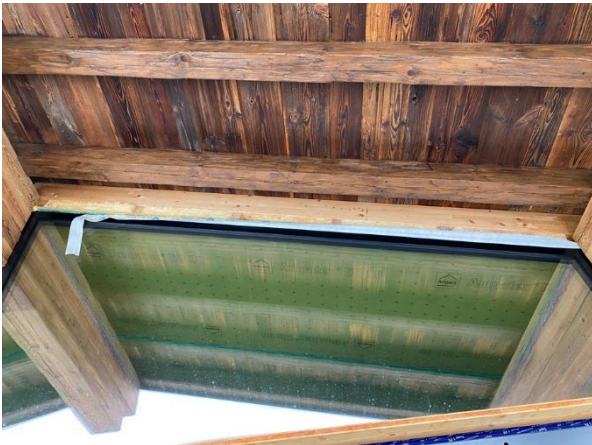
Abbildung 163, OG, Untersichten Dach Süd
