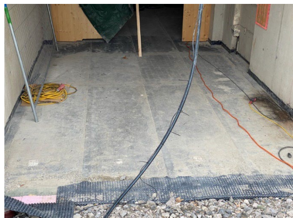
Abbildung 50, UG 1, Einfahrt Tiefgarage
