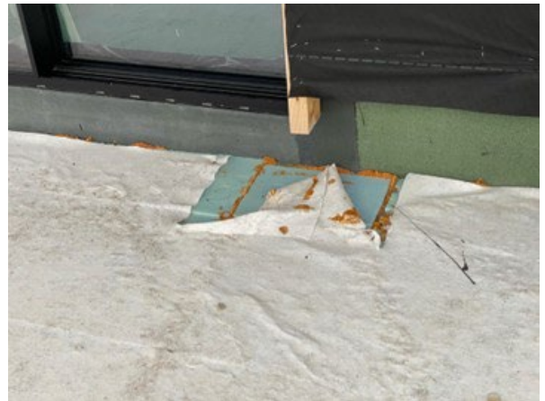
Abbildung 128, EG, Terrassendämmung+Vlies
