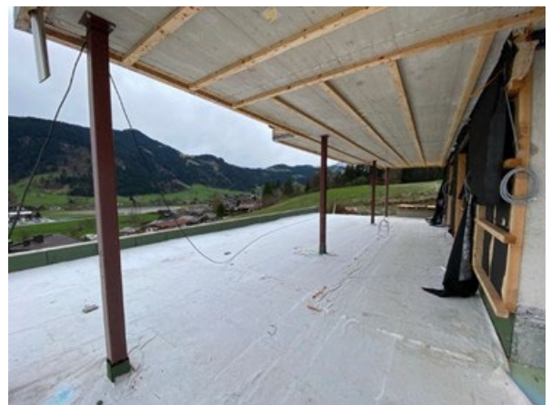
Abbildung 122, EG, Terrasse West
