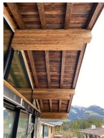
Abbildung 162, OG, Untersichten Dach Süd
