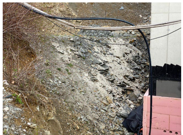
Abbildung 34, Aushub mit Felsabbruch
