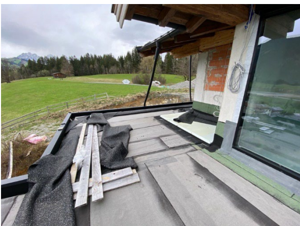
Abbildung 169, OG, Balkon Nord-West
