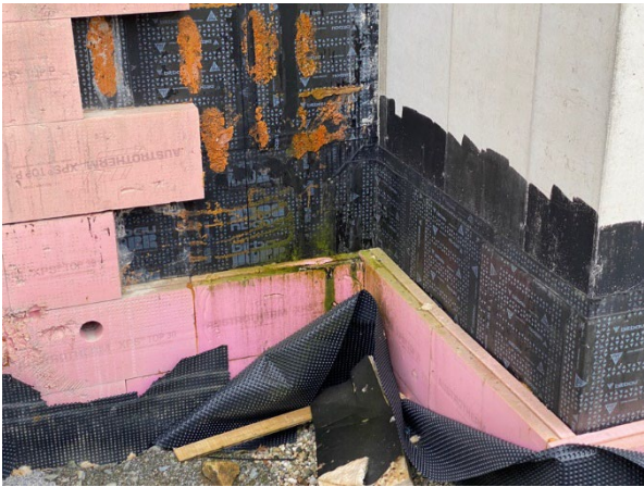
Abbildung 43, beschädigte Perimeterdämmung
