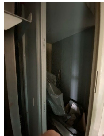
Abbildung 154, EG, Vorraum, Aufzugskabine
