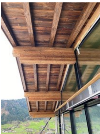
Abbildung 161, OG, Untersichten Dach Süd
