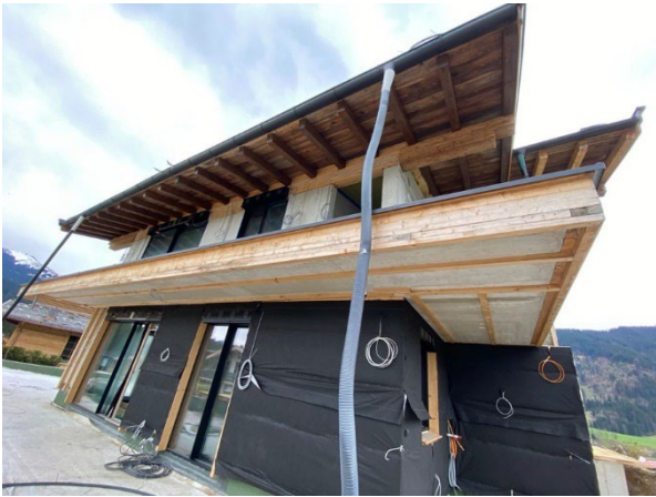
Abbildung 155, EG, Untersichten Balkon+Dach
