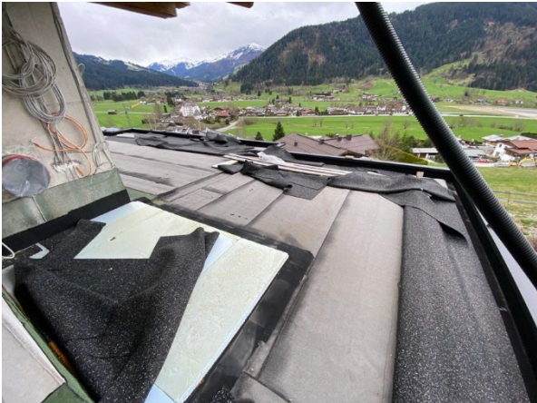
Abbildung 173, OG, Balkon Nord-West
