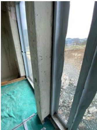
Abbildung 149, EG, Vorraum, Fensteranschlüsse
