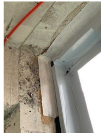
Abbildung 150, EG, Vorraum, Fensteranschlüsse
