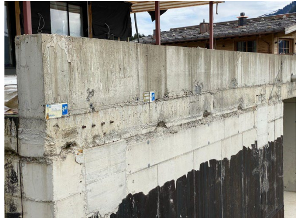
Abbildung 38, Betonschäden
