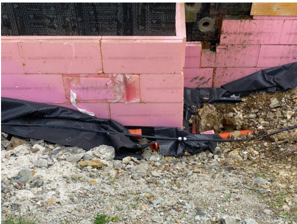
Abbildung 39, beschädigte Perimeterdämmung
