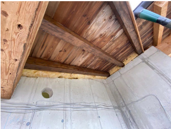
Abbildung 157, OG, Untersichten Dach
