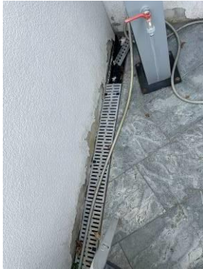
Putzabplatzungen im Bereich der Außendusche
