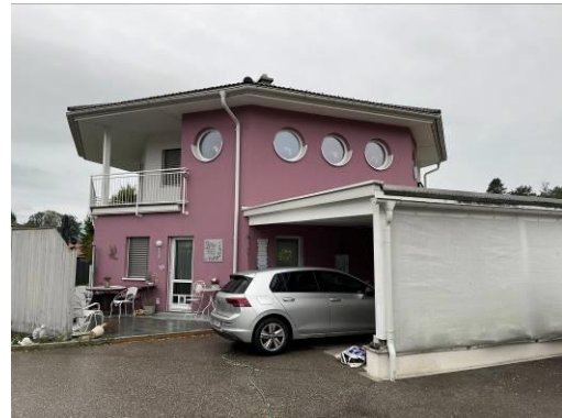
Ostansicht mit Carport und Sichtschutz
