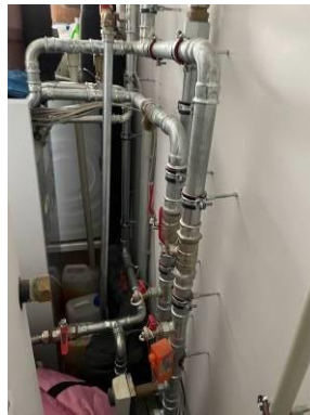
Zentralheizungsanlage der Firma Vaillant mit Leitungen auf Putz
