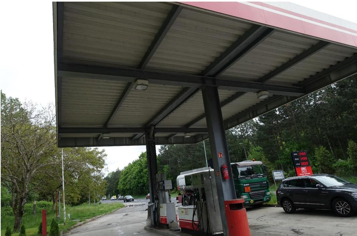
Foto 4 – Tankstellenüberdachung (Flugdach)
