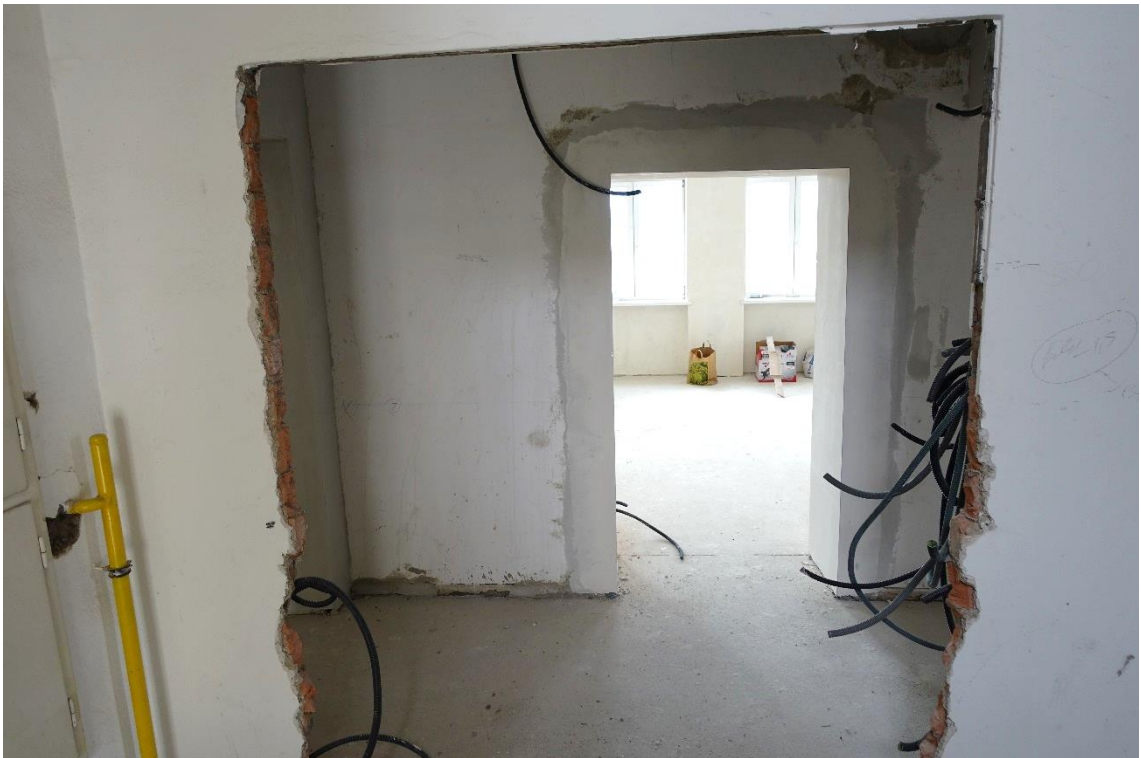
Foto 20 – Durchbruch in Stiegenhauswand
