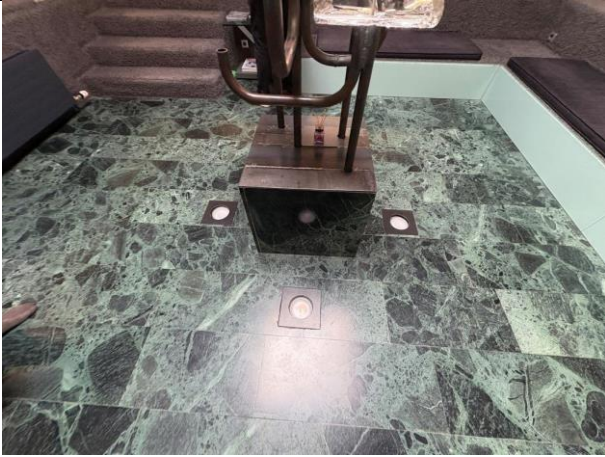
Abbildung 86: Halle – Detailansicht Boden
