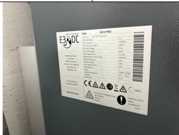
Abbildung 185: Haustechnik - E3DC Pro PV- Typenschild
