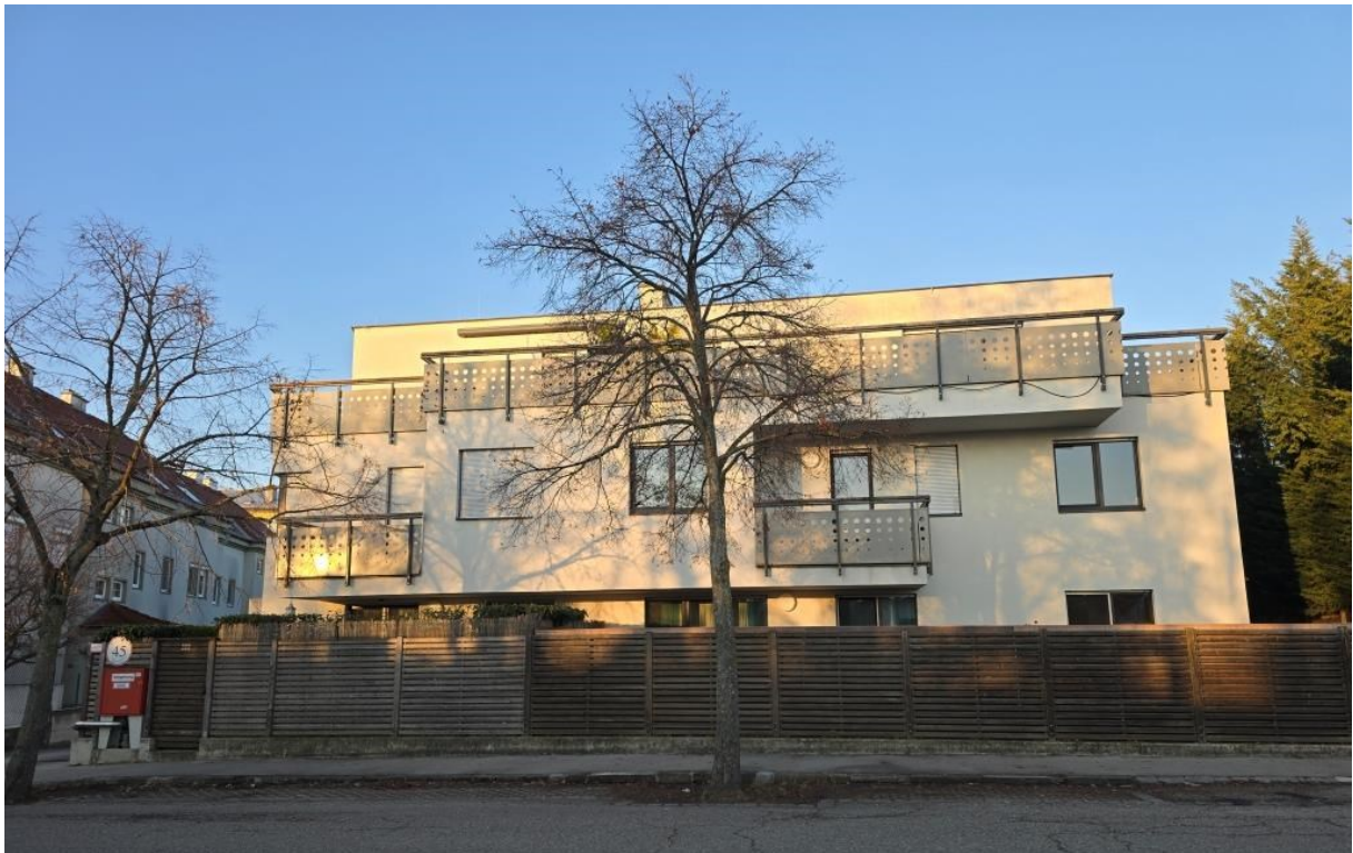
Ansicht Biondegasse (Haus 2) mit Garagenzufahrt
