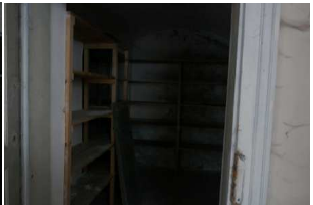
Vorraum 2 auf Höhe des Treppenhauses Parterre 4, ohne Zusammenhang mit dem Technikraum auf Höhe Parterre 5
