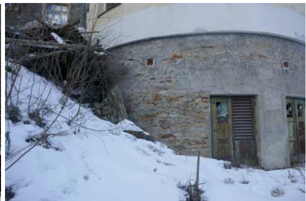
Sicht zum Anbau von Osten/Talseite Parterre 5
