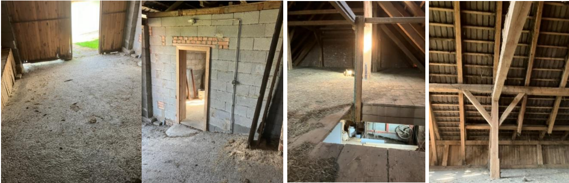
Tennen Auffahrt betoniert, Lagerraum 3 x 3 Meter, Obertenne mit Holzkonstruktion
