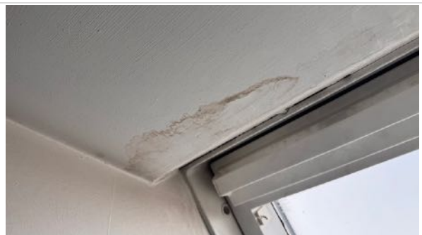
Feuchteschäden im Bereich DFF im Badezimmer
