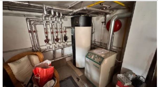
Gasheizung, vermutlich aus 2002
