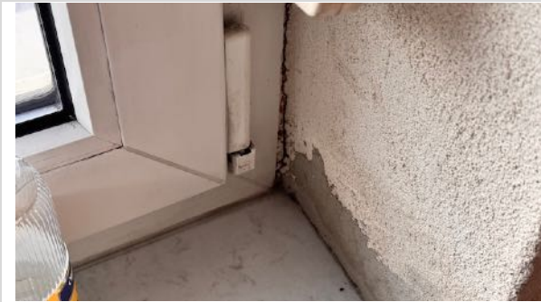
Schadhafter Wandanschlussbereich
