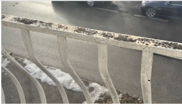
Abgeplatzte Geländerlackierung im Balkonbereich
