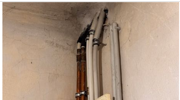
Nicht professionell verlegte Leitungen und Rohre
