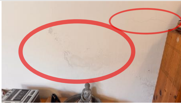
Salpeterschäden und Rissbildung im Mauerwerk
