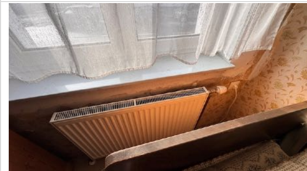
Schadhafter Wandanschlussbereich
