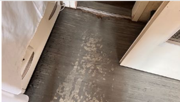
Beschädigter Linoleumboden
