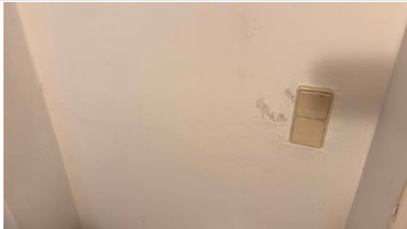
Schäden im Putzbereich bei Schalter
