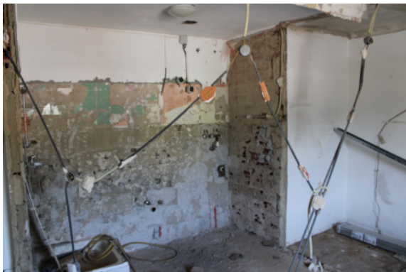
Bild 33: Wohnung 1. OG – Stiege 2 (Abbrucharbeiten)
