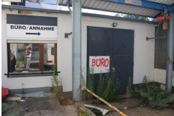
Bild 49: Gewerbeobjekt – Einfahrt Halle Ostseite
