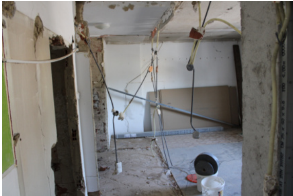
Bild 31: Wohnung 1. OG – Stiege 2 (Abbrucharbeiten)
