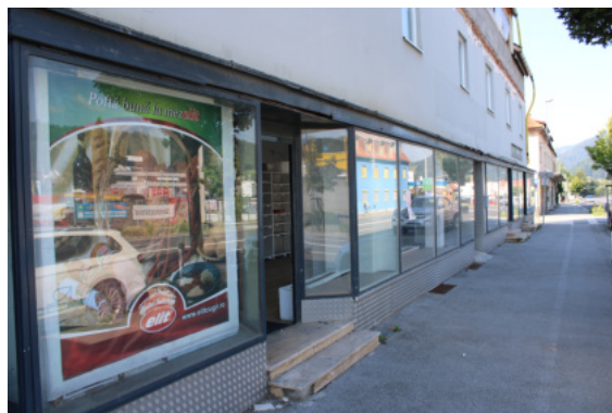
Bild 4: Ansicht Nordseite (Portale EG)
