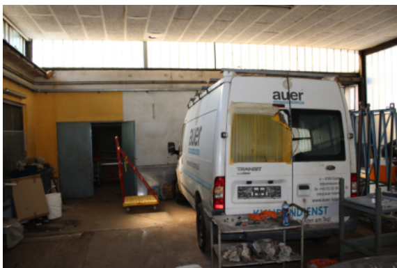
Bild 59: Gewerbeobjekt - Halle Westseite
