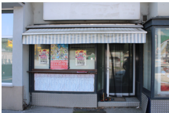
Bild 5: Ansicht Nordseite – Eingang Geschäftslokal 1
