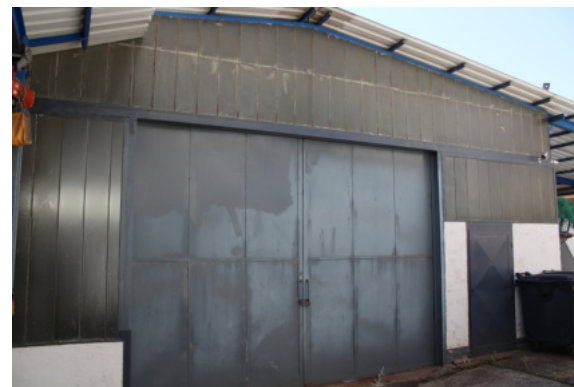
Bild 48: Gewerbeobjekt – Einfahrt Halle Westseite
