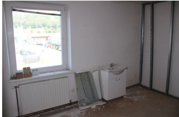
Bild 32: Wohnung 1. OG – Stiege 2 (Abbrucharbeiten)
