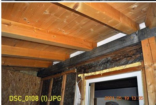
Terrassenwände und Decke ohne Dämmung
