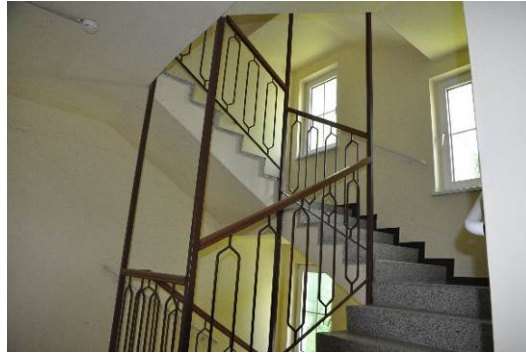
hinteres Stiegenhaus HP-1 OG
