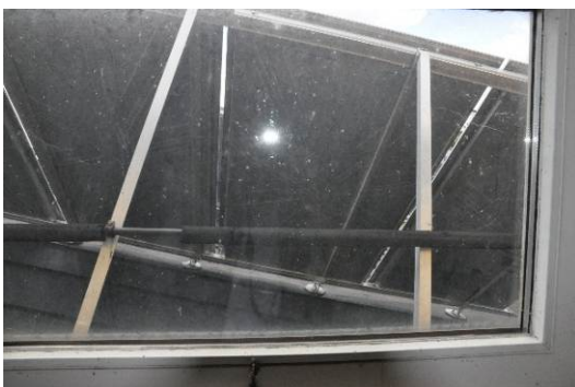
PV Anlage am Dach
