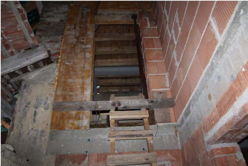
Die Konstruktion in diesem Bereich ist ebenfalls im Rohbau, wobei die provisorische Dachabdeckung zum Teil beschädigt ist und auf Grund von erheblichen Wassereintritten die OSB-Platten, die über der Stahlholzkonstruktion liegen, durch Feuchtigkeit aufgeweicht sind.
