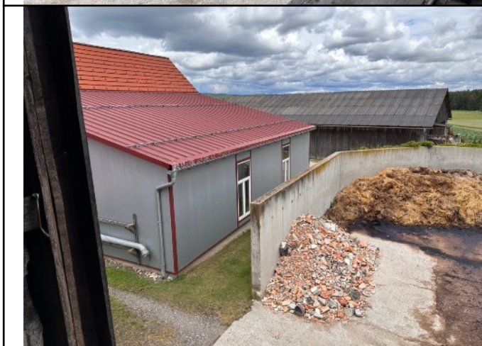
Garage für Geräte und Maschinen samt Werkstätte
