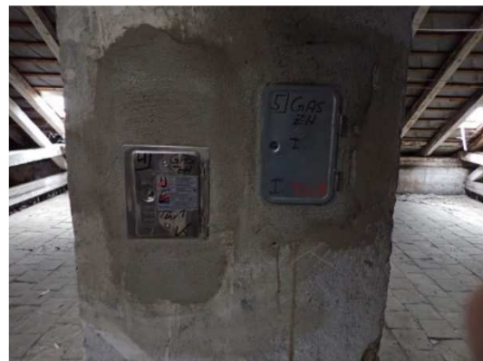
Dachraum, Kamin mit Putztürl
