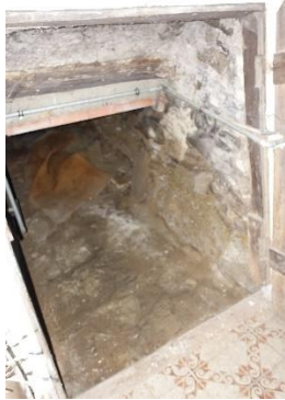
Treppe EG/Kellerraum: Natursteintreppe;
