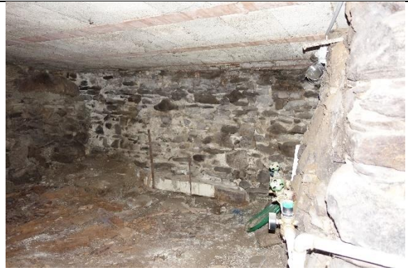
Kellerraum: Boden: Naturboden; Wände: Steinmauerwerk unverputzt; Decke: Beton-Fertigteildecke;
