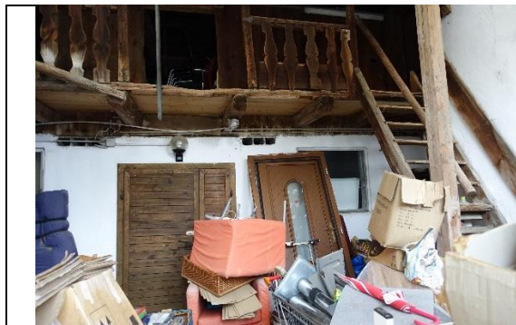
Wirtschaftsgebäude: ehemaliger Rinderstall: Südansicht
