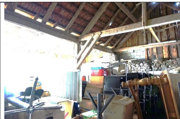
Scheune: Boden: Beton; Wände: teilweise Bretterschalung, teilweise Steinmauerwerk; Decke: offen bis Dachuntersicht;
