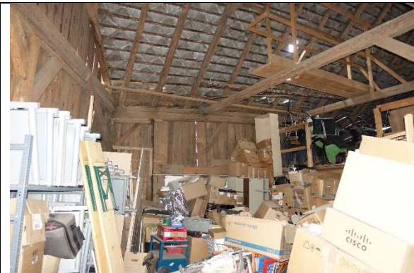
Scheune: Boden: Beton; Wände: teilweise Bretterschalung, teilweise Steinmauerwerk; Decke: offen bis Dachuntersicht;
