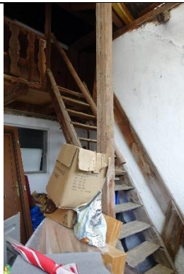
Außentreppe in den Dachboden: Holzwangentreppe mit Trittstufen;
