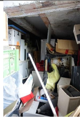
Abstellraum 3 – ehemaliger Schweinestall: Boden: Beton; Wände: verputzt und geweißt; Decke: Fertigteildecke: unverputzt;
