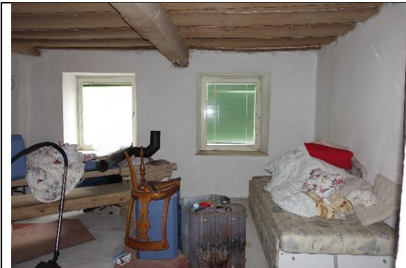
Zimmer 1: Boden: Estrich; Wände: verputzt und gemalt; Decke: teilw. verputzt und gemalt; teilw. Holzdecke mit geschnitztem Balken;
