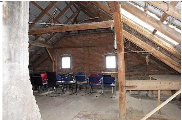
Dachboden: Boden: teilweise Beschüttung, teilweise Bretterbelag;
