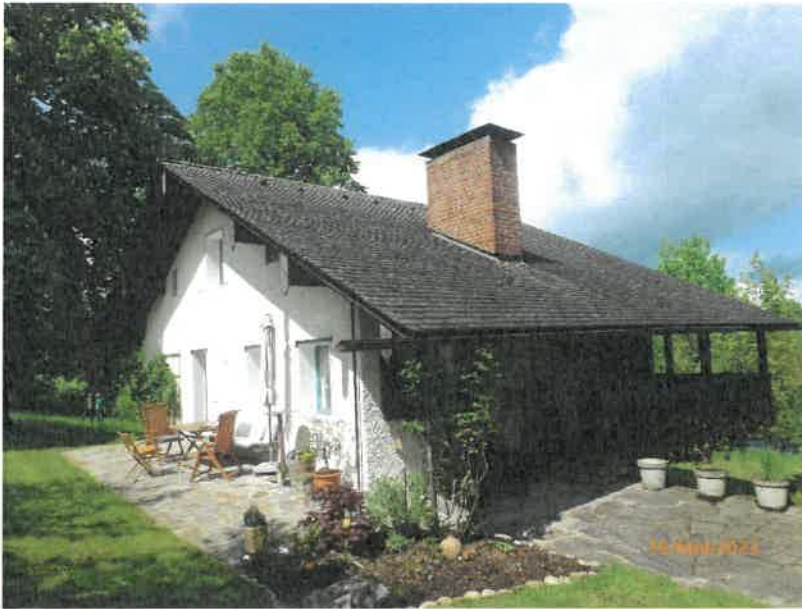
Ansicht aus Richtung Süden
