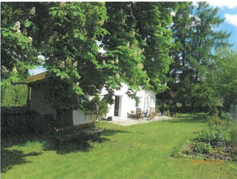
Ansicht aus Richtung Westen
