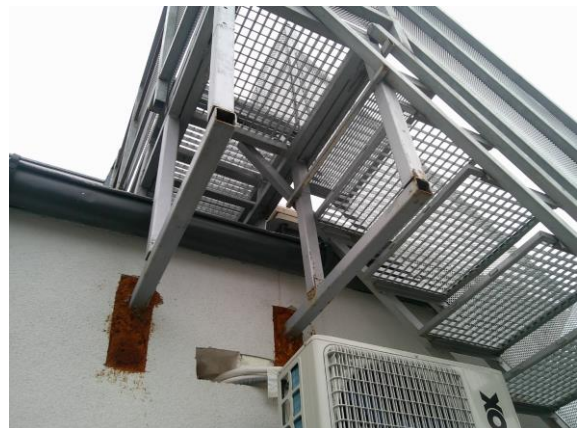
Foto 40: Top 14 | Aufgang auf die Dachterrasse
