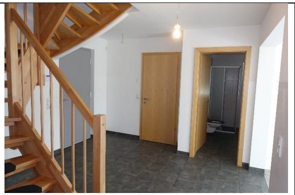
Diele: Boden: Fliesen; Wände und Decke: gespachtelt und gemalt;
