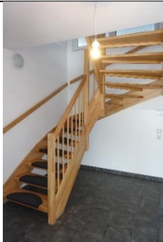
Treppe EG/OG: gefächerte Massivholzwangentreppe mit Massivholz-Trittstufen, Massivholzgeländer;
