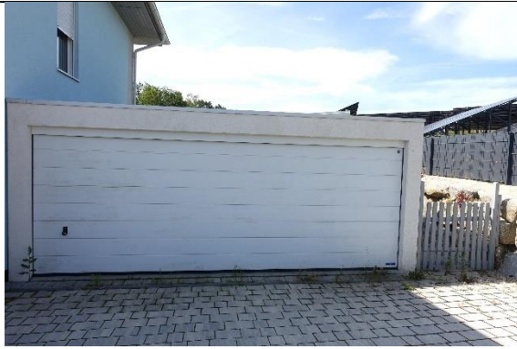
Großraumgarage (Fabrikat Zapf): Boden: Beton; Wände: Stahlbeton; Dach: Flachdach mit Isolierung und Kiesschüttung; 1 Deckensektionaltor mit elektrischem Antrieb und Funkfernsteuerung;
