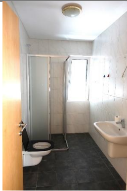
Bad/WC: Boden: Fliesen; Wände: Fliesen; Decke: gespachtelt und gemalt; Sanitär-ausstattung: 1 Waschbecken mit Armatur, 1 Eck-dusche mit Duschschiebetrennwand und Armatur, 1 Hänge-WC mit Unterputzspülkasten;
