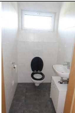
WC: Boden: Fliesen; Wände: Fliesen; Decke: gespachtelt und gemalt; Sanitärausstattung: 1 Hänge-WC mit Unterputzpülkasten, 1 Handwaschbecken;
