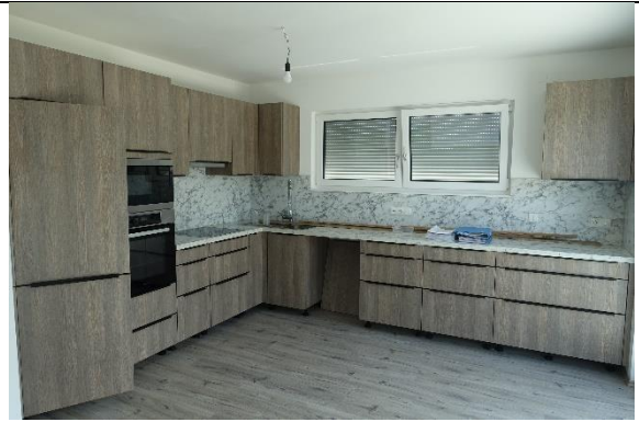
Küche: Boden: Laminatboden; Wände und Decke: gespachtelt und gemalt; Zubehör: ein L-förmiger Einbauküchenblock mit Unter- und Oberschränken; Fronten und Arbeitsplatten beschichtet; Einbauten: 1 Mikrowelle, 1 Backrohr (Fabr. Miele), 1 Ceranfeld, 1 Dunstabzug, 1 Nirosta-Spüle mit Armatur, 1 Kühl-Gefrierkombination, Einbau im Jahr ca. 2018;
