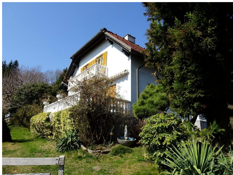
Gebäudeansicht mit Terrasse südost
