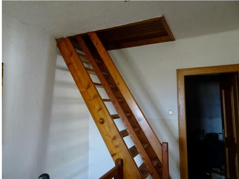
Zugleiter in den Spitzboden
