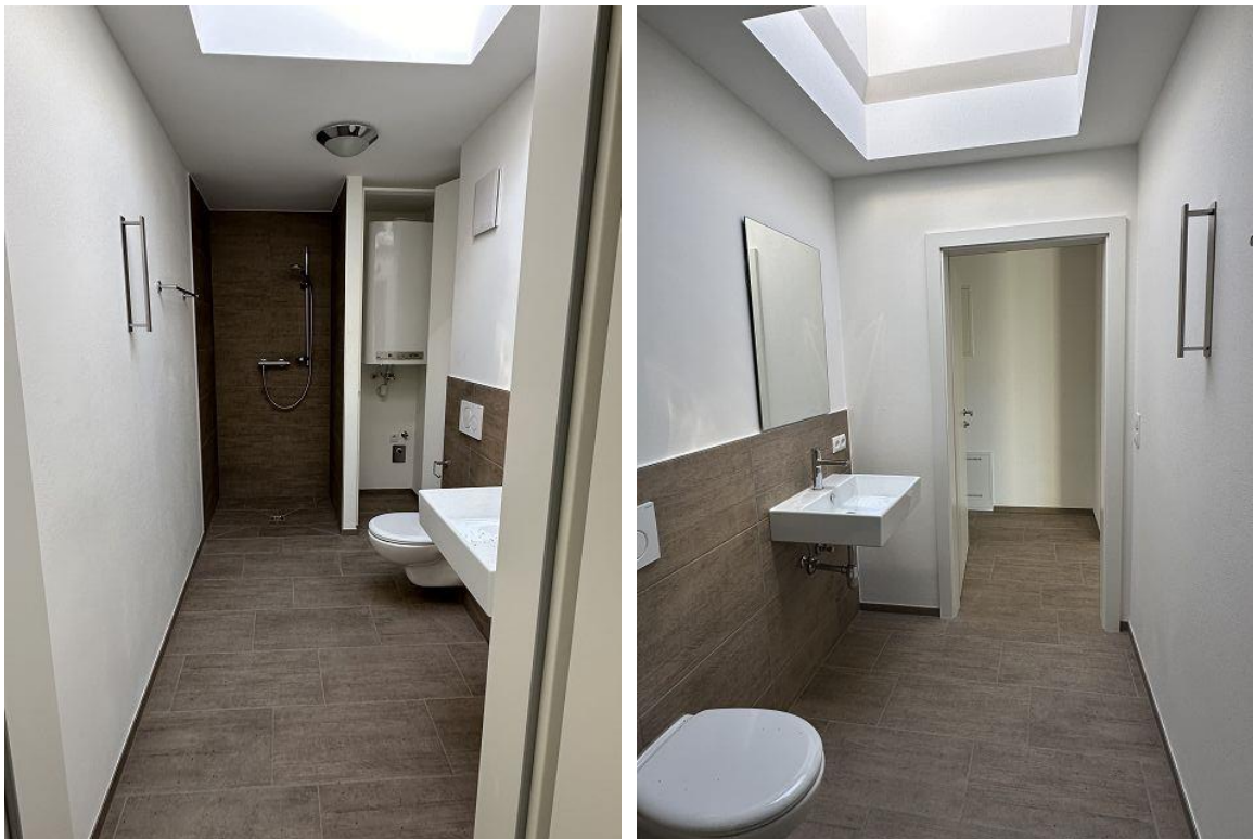
Bad mit Dusche, Waschbecken und WC
