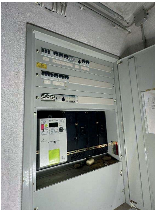
Zählerverteiler
