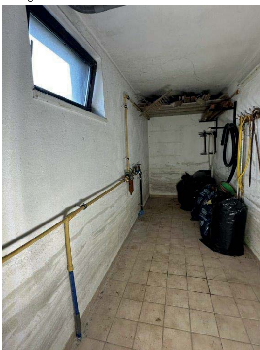
Wasseranschluss mit Wasseruhr
