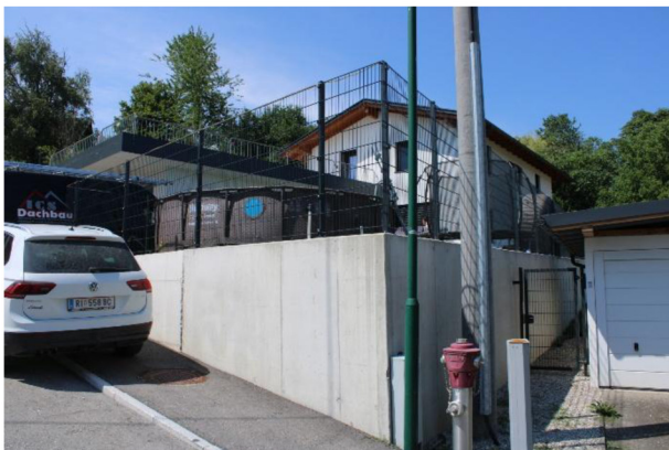
Ansicht von Straße mit Teil der Stützmauern (Süden)
