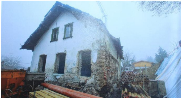
Ursprünglicher Zustand (Altbau vor Kernsanierung))
