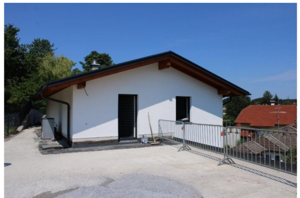
Dachterrasse im OG von Süden (Fertigstellungsbedarf)
