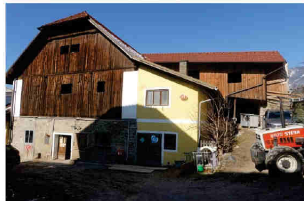
Wirtschaftsgebäude von Südosten
