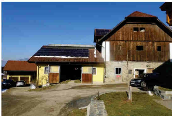
Wirtschaftsgebäude von Südosten
