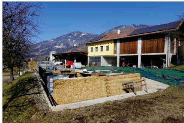
Maschinenhalle; Laufstall von Südosten
