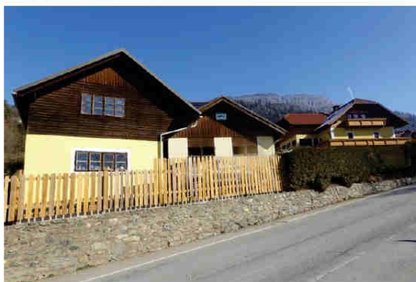
Hofstelle von Süden
