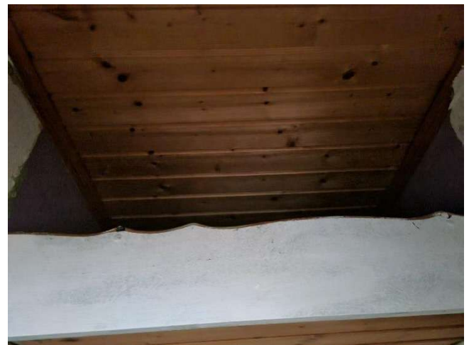
Bild 14 von 28 Blick auf die Zwischendecke im WC
