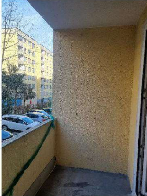
Bild 21 von 28 Blick auf die Loggia
