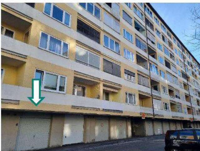
Bild 27 von 28 Blick auf die Garage XXVIII (mittels Pfeils gekennzeichnet)
