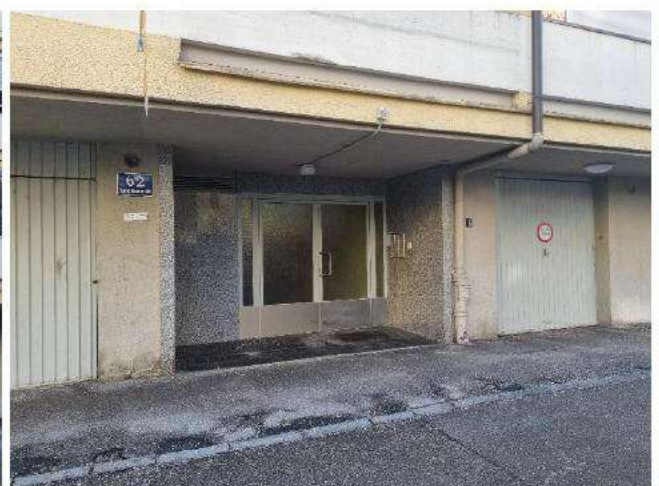
Bild 4 von 28 Blick auf den Zugangsbereich
