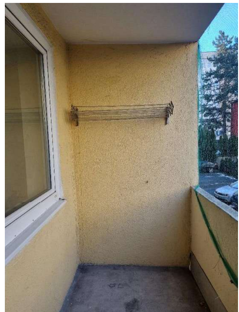
Bild 20 von 28 Blick auf die Loggia
