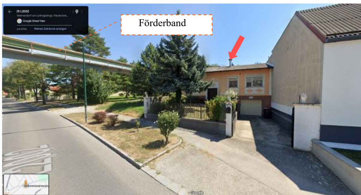
Abbildung 8: Nachbarschaftsbebauung mit Ergänzung SV (Pfeil); Quelle: google.com/maps/
