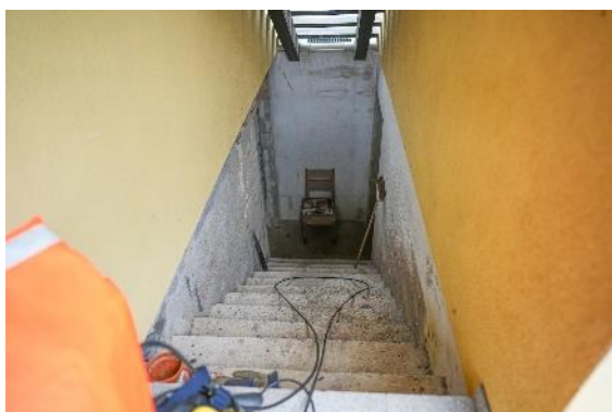
Außentreppe ins KG
