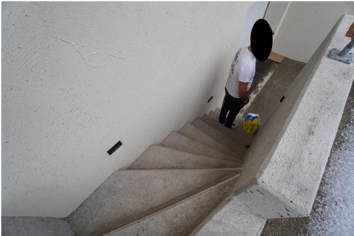
Außentreppe zum Untergeschoß
