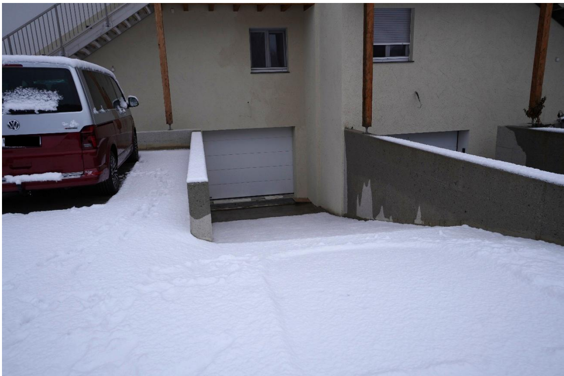
Rampe ins Untergeschoß
