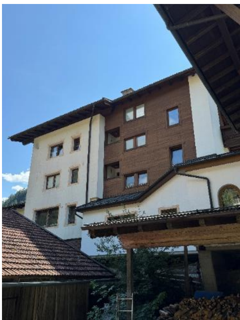
Bild 3 von 60 Ansicht aus Westen
