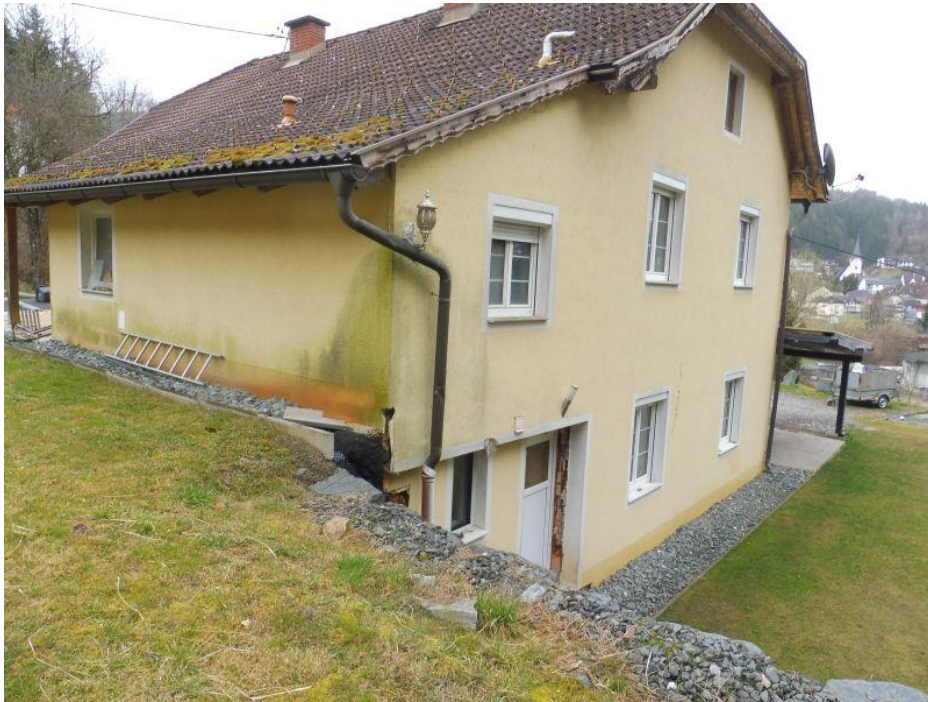
Teilansicht West- und Südseite (oben)
