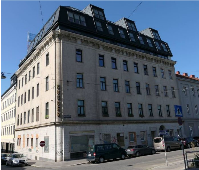
Ansicht Anschützgasse/ Schwendergasse
