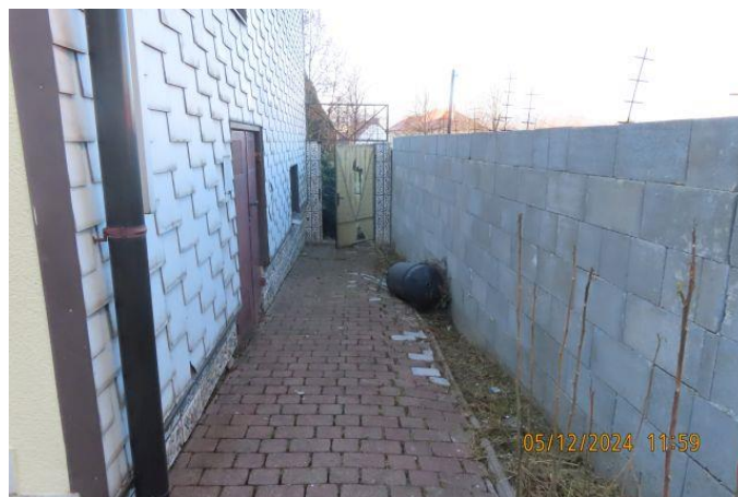
Abb. 9: Wohnhaus Südansicht mit Kellerzugang
