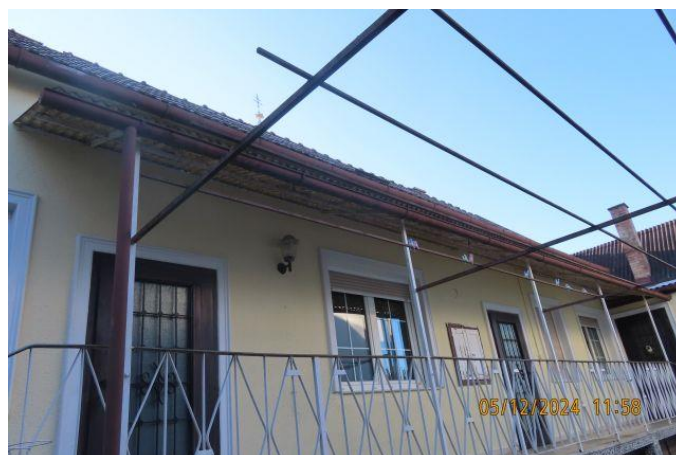
Abb. 10: Wohnhaus mit Laubengang Hofansicht
