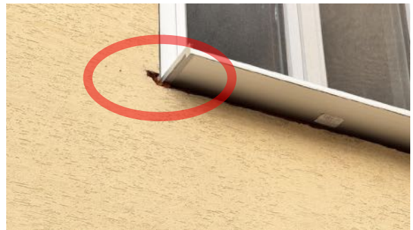
Unfertige Anschlussarbeiten
