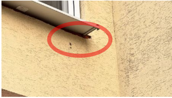
Unfertige Anschlussarbeiten
