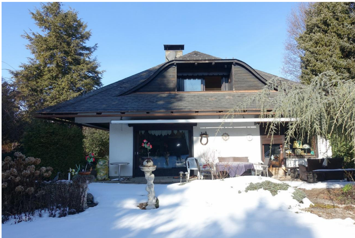
SÜD-OSTANSICHT MIT TERRASSE - FOTO 3
